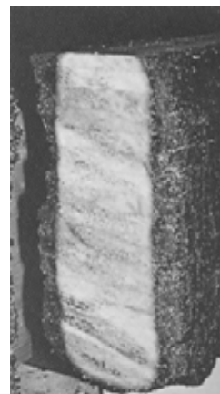
Figura 3.13: Trave di legno sottoposta ad incendio. Sotto lo strato carbonizzato il legno è ancora efficiente dal punto di vista meccanico.
