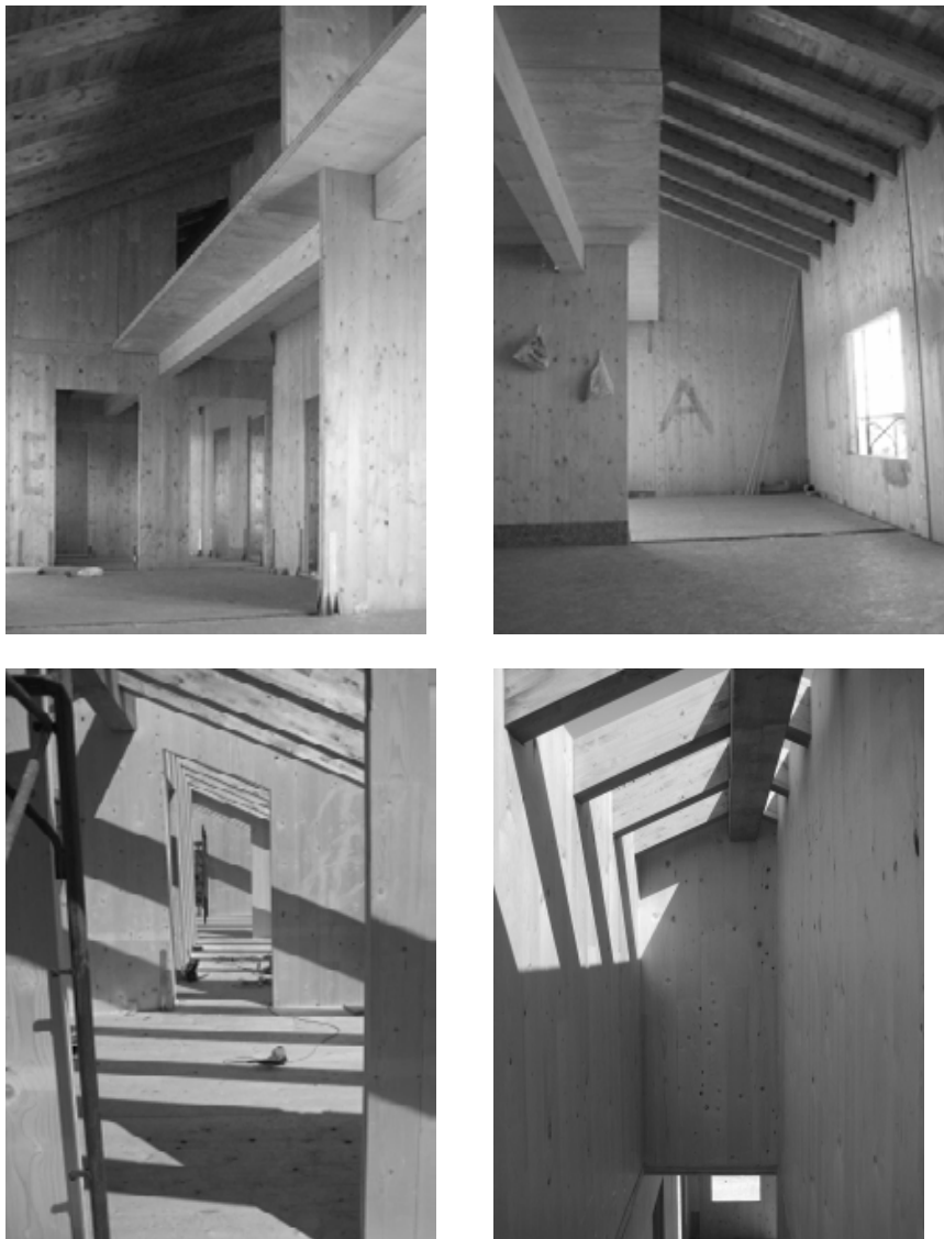
Figura 7.4: Viste della struttura montata. Dopo soli due giorni e mezzo il committente può avere un'idea precisa dell'aspetto finale della sua abitazione.
