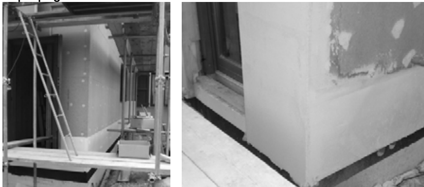
Figura 3.17: L'edificio, realizzato con struttura a pannelli di legno massiccio a strati incrociati, è rivestito con pannelli di fibra di legno aderenti alla struttura; il successivo strato di intonaco rende la superficie non infiammabile e impedisce la propagazione del fuoco in facciata.
