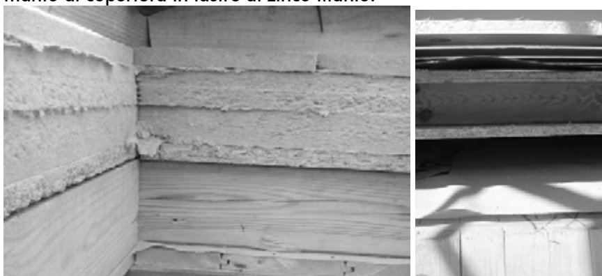
Figura 7.5: Stratigrafia della copertura e intercapedine di ventilazione
