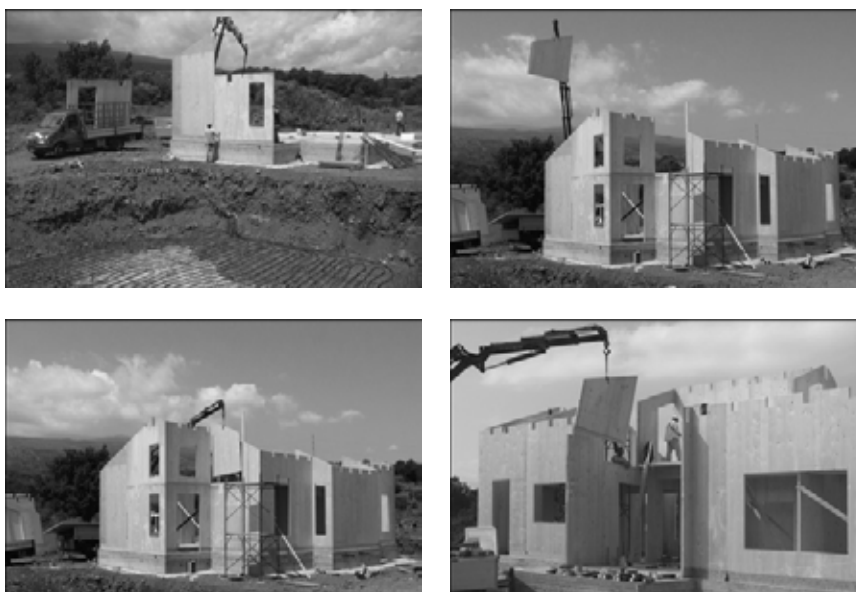
Figura 7.3: Fasi di montaggio della struttura.
