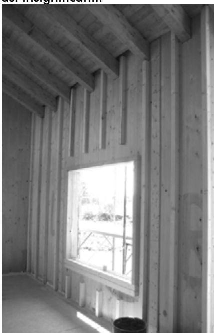
Figura 5.4: Parete di un edificio Xlam.
