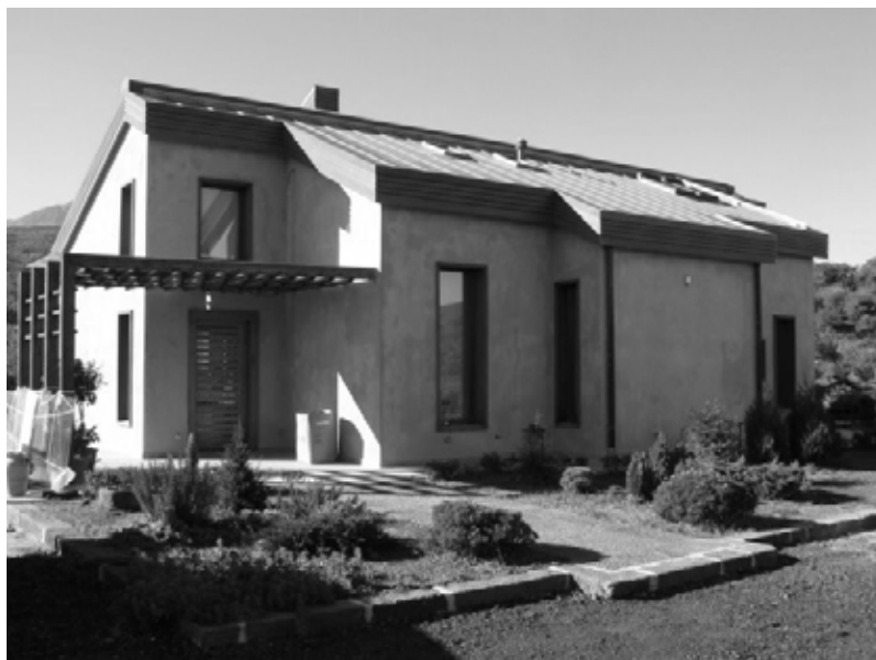
Figura 7.9: Edificio completato dall'esterno.
