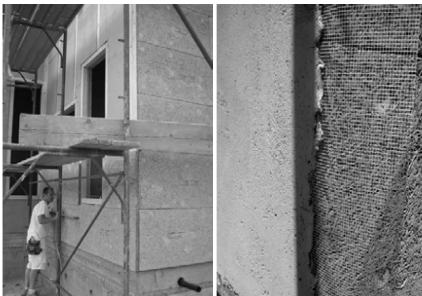
Figura 7.6: Posa in opera del cappotto esterno.
