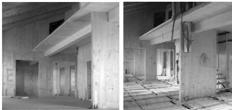
Figura 5.6: Casa per civile abitazione, spazi interni definiti dagli elementi strutturali in pannelli di legno portanti ed integrazione tecnologica di pavimento radiante (Casa Mazza, Linguaglossa, Catania).
